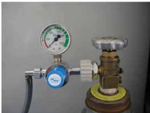
Slika 6: Regulator tlaka dušikovega oksidula in označeno mesto njegovega uhajanja.
